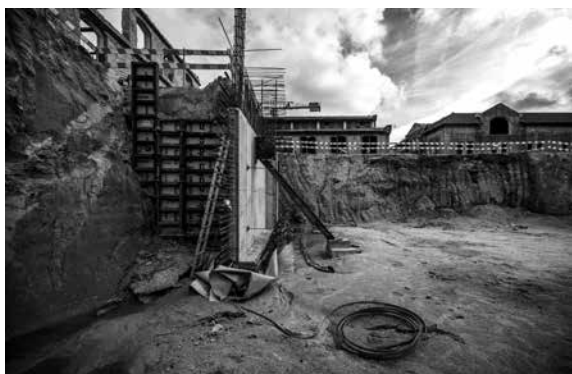
Execução das escavações para os edifícios com piso de cave - edifícios HR e AB
