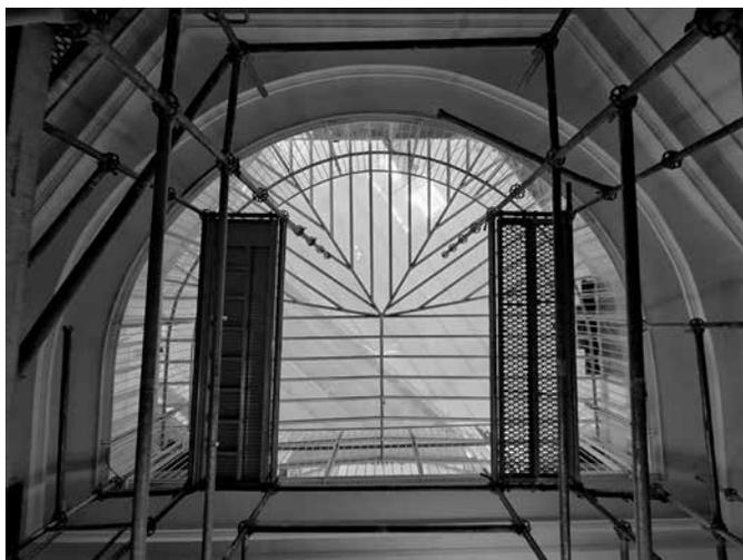
Demolição de lage e instalação da nova clarabóia
