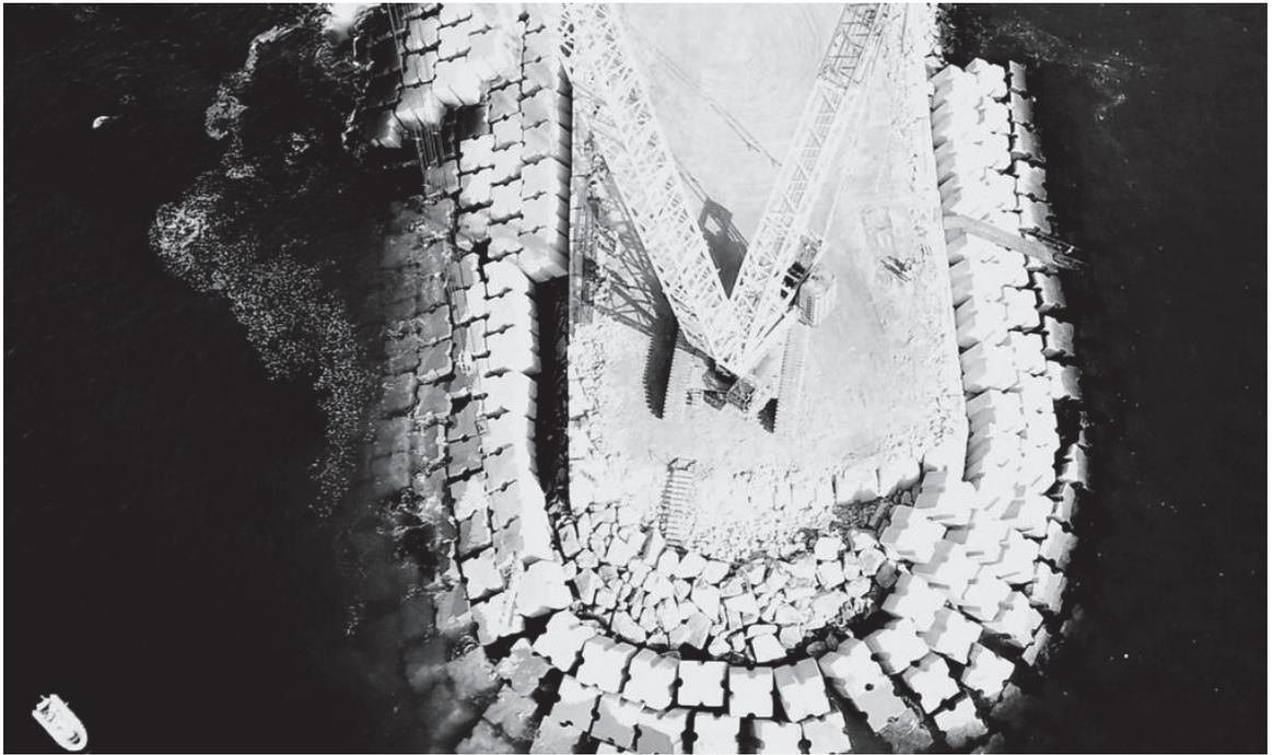
O estaleiro principal está instalado na área da Plataforma Logística do Porto de Leixões. Nesta zona serão fabricados os blocos artificiais em betão (tipo *Antifer*) que constituirão o manto de proteção do quebra-mar, Fig. 10.
