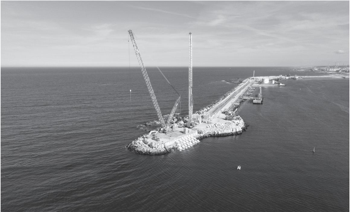
Fig. 09. Prolongamento do quebra-mar e proteção de Inverno
