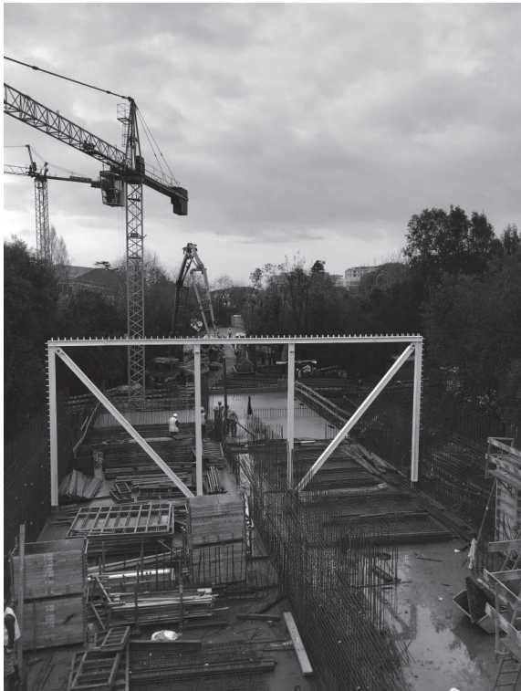
Projeto de estruturas - treliça da cobertura, corte transversal Montagem da treliça
