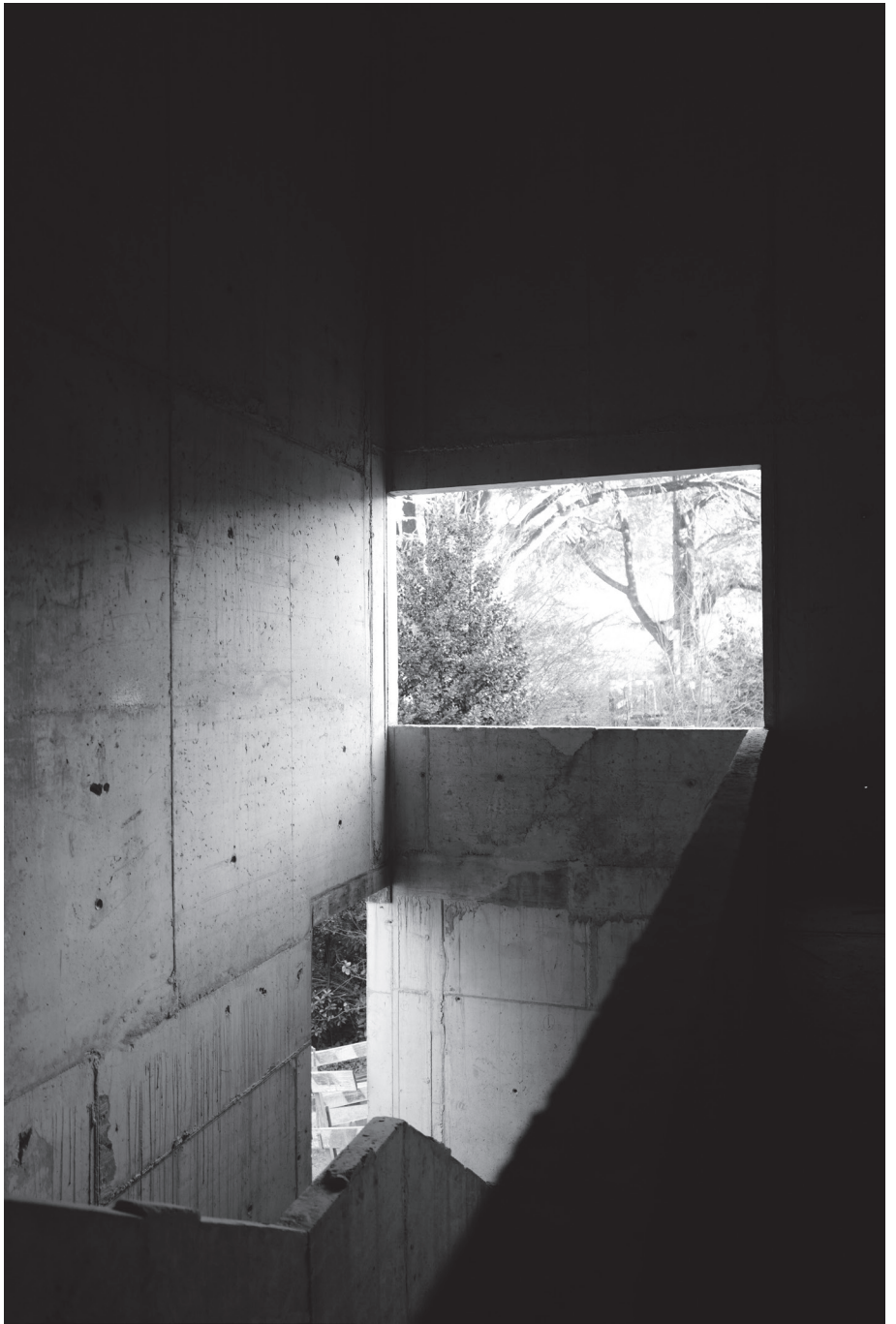
Fase de obra - caixa de escadas em tosco
