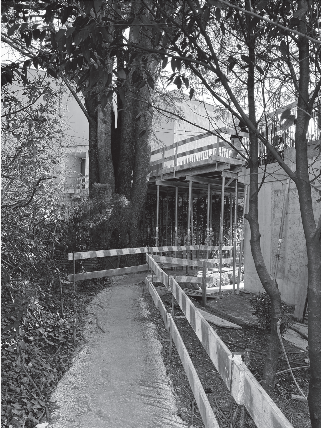
Fase de obra - ponte de passagem para o Museu vista da cota Jardim
