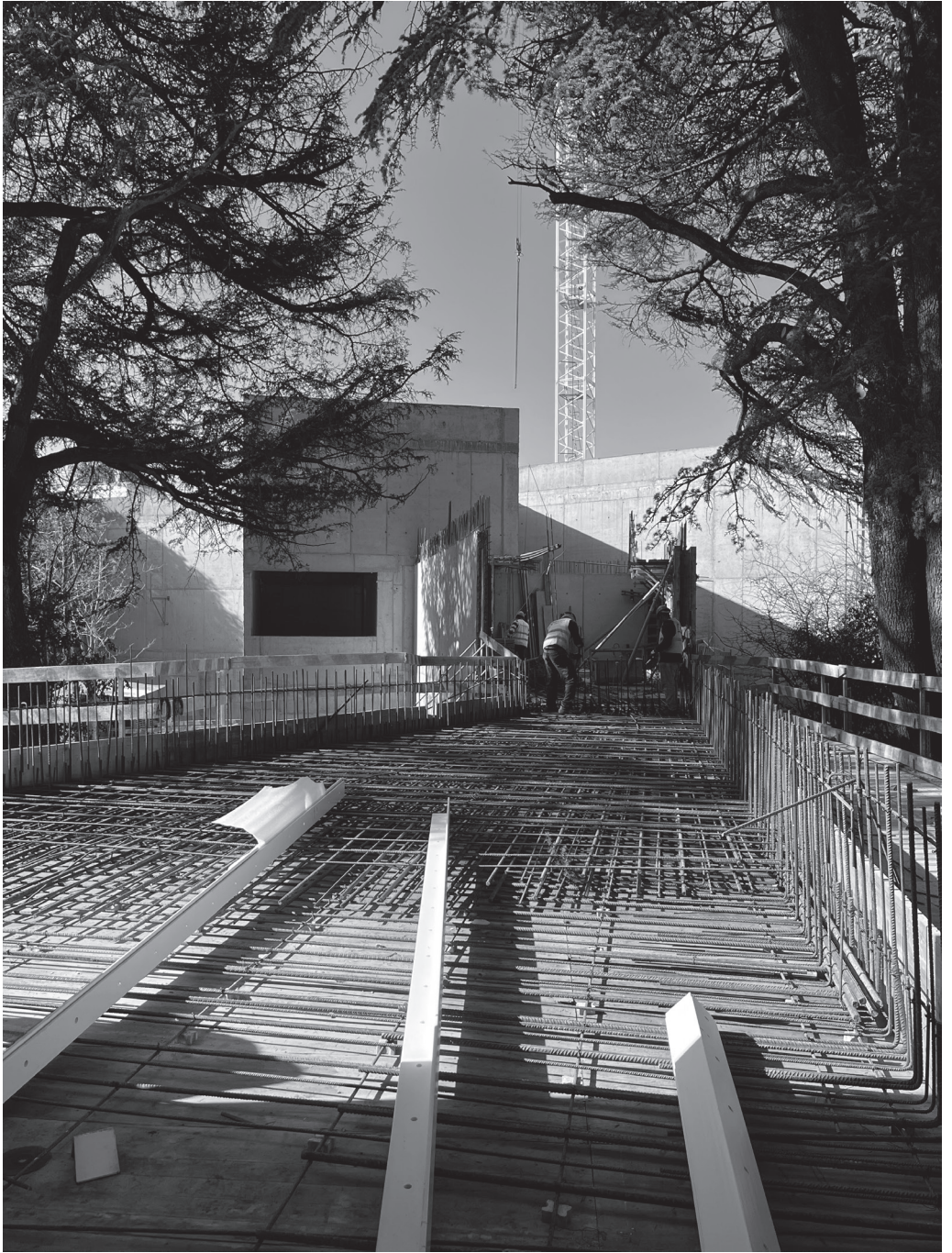
Fase de obra - ponte de passagem para o Museu vista da cota do piso 2
